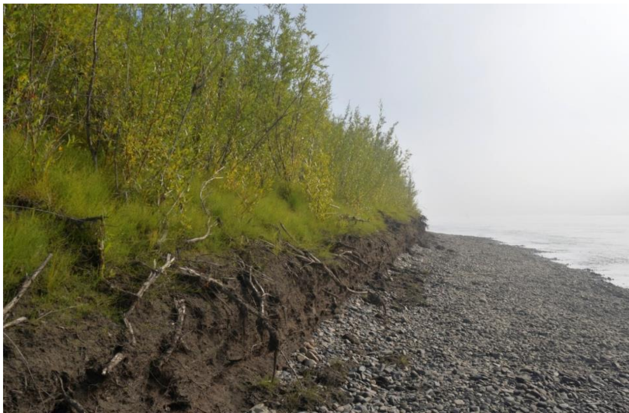
Рис. 6. Площадка № 8. Смытый участок низкопойменного ивняка. Фото О.Мочаловой.
