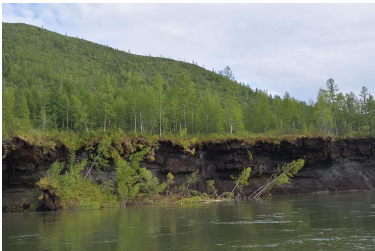
Рис. 10. Разрушающийся правый берег Колымы. Фото О.Мочаловой.
